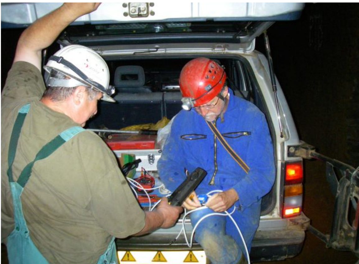
Die Stecker werden am Kabel befestigt.
