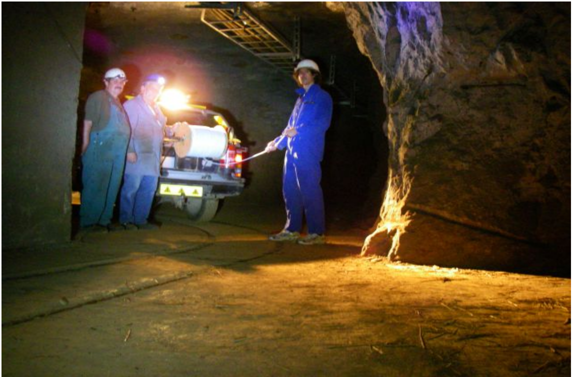
Im Bergwerk wird das Kabel ausgerollt und verlegt.
